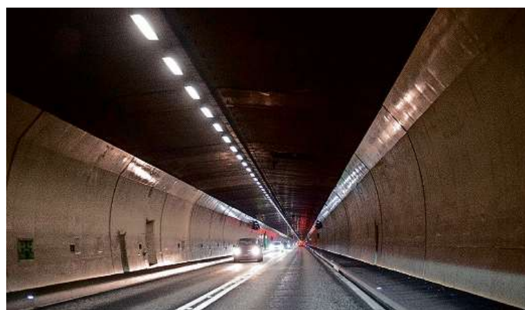
Schäden an der Fahrbahn: Der Klosterser Gotschnatunnel wird während seiner Sanierung insgesamt 34 Wochen für den Verkehr gesperrt bleiben. Bild Stefanie Studer
